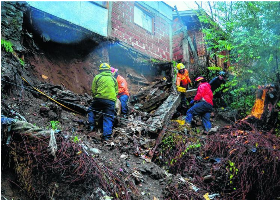
Imagen 10: Deslizamiento en pendiente urbanizada del cerro Cte Díaz. Fuente: diario Río Negro.
