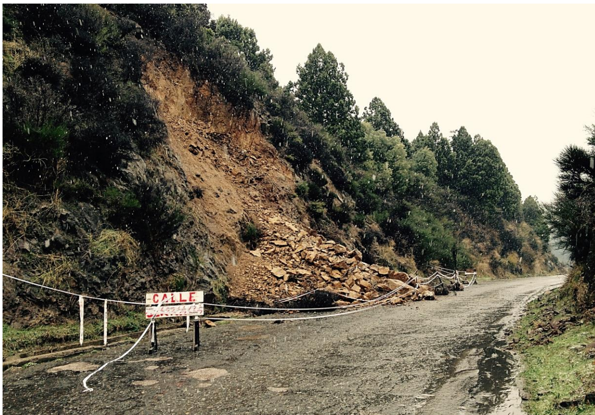
Imagen 7: Desprendimiento de rocas sobre acceso a ex hotel Sol de los Andes. Fuente: propia.
